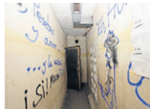
Verwinkelt, verschachtelt und „verziert“: das Innere des Betonklotzes am Georg-Bitter-Weg.
