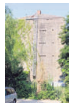
Die rückwärtige Ansicht des Bunkers.
